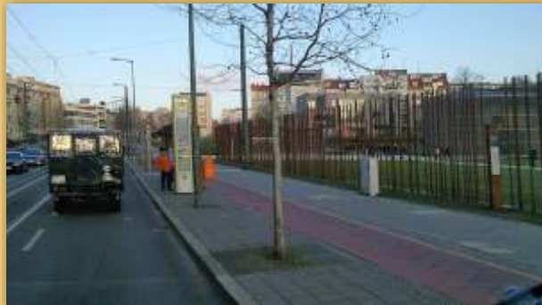
Restmauer ohne Beton (Stahlstäbe)
